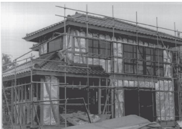
図1 在来木造軸組構法における断熱化
