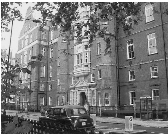
クリニックのある Brompton Hospital ロンドンで多く見られるレンガ造りの建物。 ただしかなり古い。
