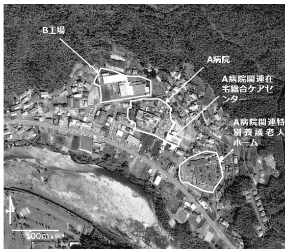
図1 A病院ならびに関連施設とB工場の位置関係。両者の敷地は幅員6mの町道を隔て隣接している。
