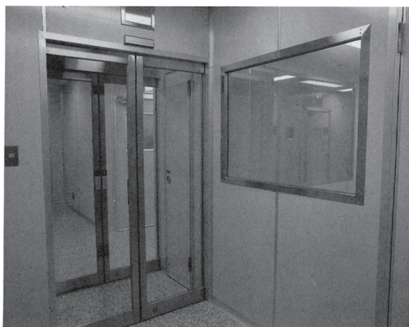
図2 ドアは二重になっていて、外界の空気から遮断されている。
